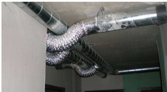
VMC DF : Points bas et utilisation de gaines souples difficiles à nettoyer
