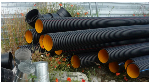
Stockage des gaines d'un puits canadien à l'extérieur et sans protections
