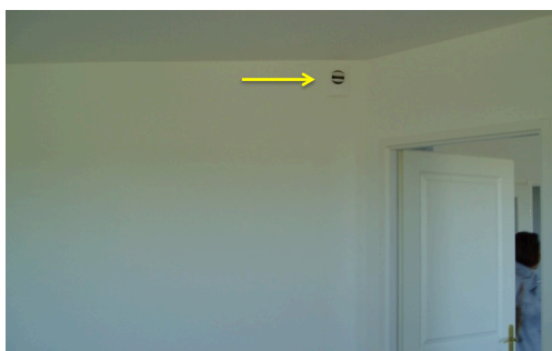
Positionnement inadéquate des bouches d'insufflation ne permettant pas un bon renouvellement de l'air dans le fond de la pièce
