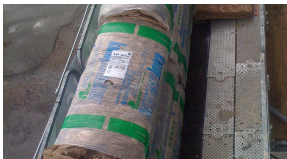
Mise en œuvre d'isolants humides
