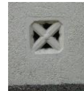
Entrée d'air dans le VS
