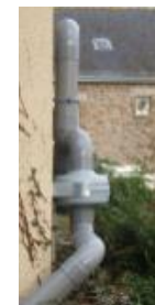
Extraction mécanique du VS
