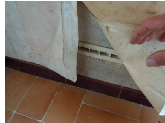
Bouche d'entrée d'air sous le papier peint
