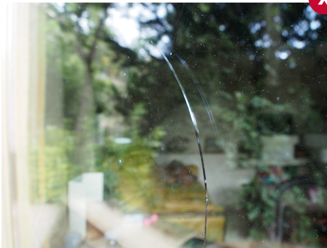
Menuiserie triple vitrage fêlée lors du transport par manque de protection.
